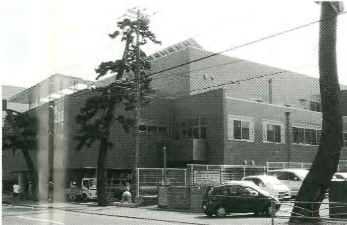
①山近記念クリニック②神奈川県小田原市小八幡③2,998.28㎡④SRC造、地上3階⑤杉田三郎建築設計事務所⑥2004年5月
