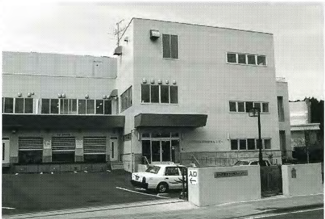
①仙台市②仙台市青葉区本沢2-7-40③M A D O 建築総合設計④ 5,797.11㎡⑤R C・S造、地下1階地上2階塔屋1階⑥2003年4月
