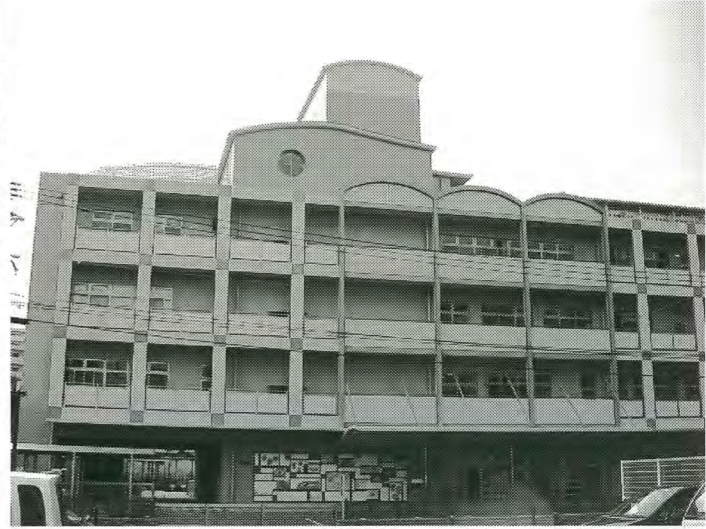
①福岡市保健福祉局障害施設課②福岡市西区姪浜町1233-9 ③匠建 築研究所④3,936.65㎡⑤RC造、地上5階⑥2002年4月
