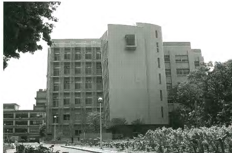
①国立大学法人名古屋大学②名古屋市中千種区不老町③安井建築設計事務所④6,913㎡⑤RC造、地下1階地上6階⑥2004年1月
