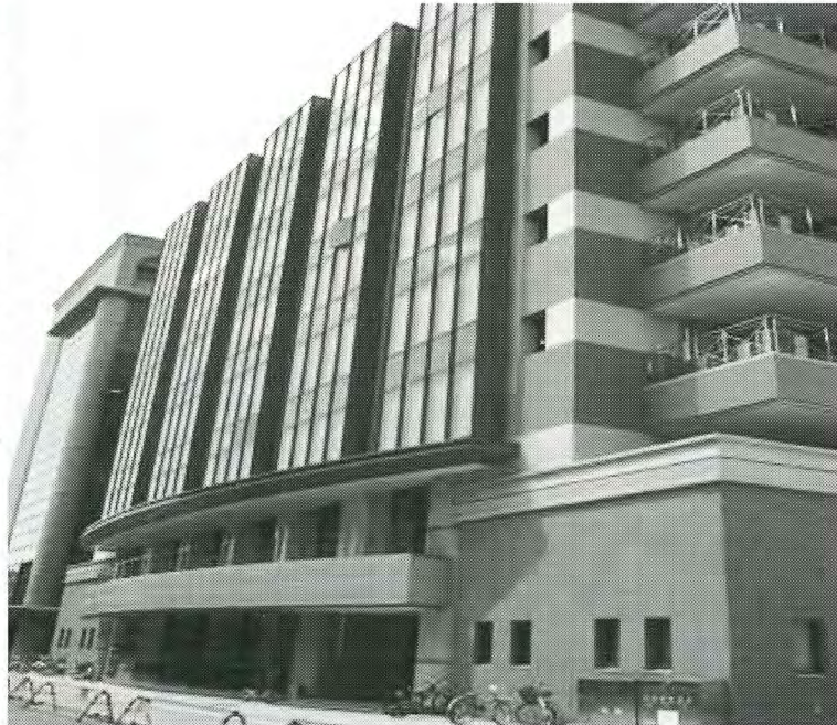
①国立大学法人九州大学②福岡市東区馬出3-1-1(九州大学堅粕団地構内)③大建設④10,562.89㎡⑤R C造、地下1階地上9階塔屋1階⑥2002年12月
