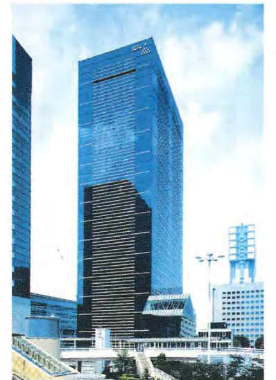
①NTTデータ②東京都港区港南1-9-36③NTTファシリティーズ④70,306.87㎡⑤S造(地下SRC造)、地下3階地上27階塔屋2階、耐震構造(オイルダンパー設置)⑥2003年6月
