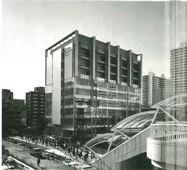
①国立大学法人東京工業大学②東京都港区芝浦3-3-6③山下設計 計④9,120.78㎡⑤SRC造(免震構造)、地上9階⑥2003年10月
