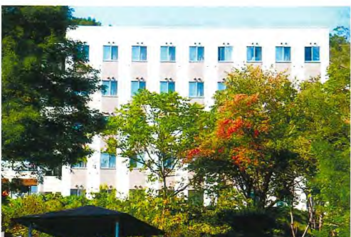
▽建築主＝小樽商科大学▽所在地＝北海道小樽市緑▽発注元＝小樽商科大学▽延べ床面積＝2,475㎡▽構造＝RC造(壁式構造)地上5階建て▽竣工年月＝2011年3月
