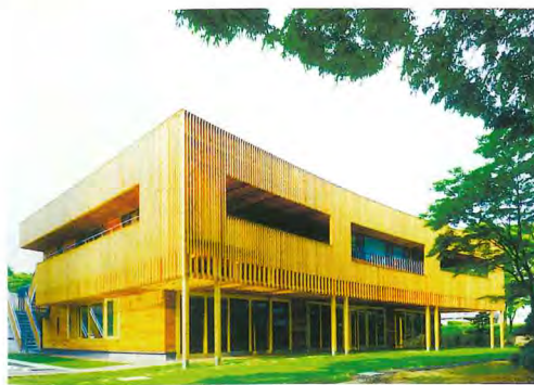
▷建築主＝東北大学▷所在地＝仙台市▷発注元＝東北大学▷延べ床面積＝997㎡▷構造＝木造地上2階建て▷竣工年月＝2010年3月
