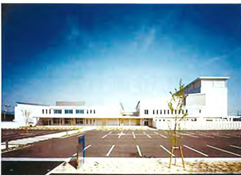
▷建築主＝尾道市▷所在地＝広島県尾道市向島町▷発注元＝中電技術コンサルタント▷延べ床面積＝4,737㎡▷構造＝SRC造地上3階建て▷竣工年月＝2008年3月
