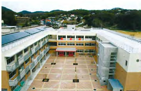
▷建築主＝岡山大学▷所在地＝岡山市▷発注元＝岡山大学▷延べ床面積＝5,252㎡▷構造＝RC造地上3階建て▷竣工年月＝2008年3月
