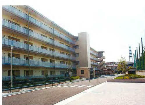
▷建築主＝大阪市▷所在地＝大阪市東淀川区瑞光▷発注元＝大阪市▷延べ床面積＝4,930㎡▷構造＝RC造地上5階建て(84戸)▷竣工年月＝2013年5月
