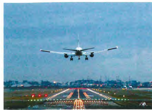
▷建築主＝大阪航空局▷所在地＝福岡市博多区▷発注元＝大阪航空局▷滑走路＝長さ2,800m、幅60m▷竣工年月＝2013年3月
