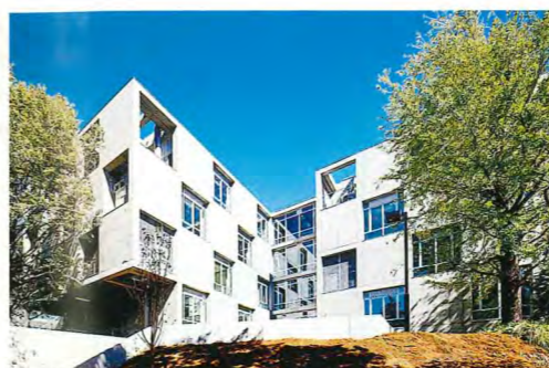
▽建築主＝東京工業大学▽所在地＝東京都目黒区▽発注元＝東京工業大学▽延べ床面積＝4,432㎡▽構造＝RC造地上1階地上4階建て▽竣工年月＝2013年10月(写真撮影協力：東京工業大学)
