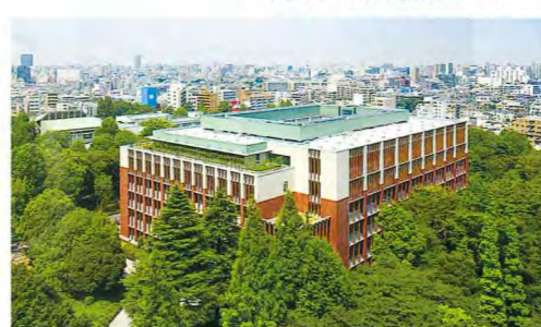
▽建築主＝筑波大学・放送大学学園▽所在地＝東京都文京区▽発注元＝筑波大学・放送大学学園▽延べ床面積＝2万1,990㎡▽構造＝SRC造地上1階地上6階建て▽竣工年月＝2011年8月
