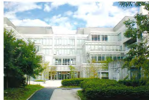
▽建築主＝東京大学▽所在地＝千葉県柏市▽発注元＝東京大学▽延べ床面積＝1万2,432㎡▽構造＝PC(RC)一部S造地上1階地上4階建て▽竣工年月＝2011年4月
