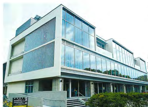
▷建築主＝三重大学▷所在地＝津市真栗町屋町▷発注元＝三重大学▷延べ床面積＝2,173㎡▷構造＝RC造地上3階建て▷竣工年月＝2012年3月
