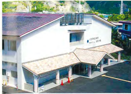
▽建築主＝小笠原村▽所在地＝東京都小笠原村父島▽発注元＝相互設計事務所▽延べ床面積＝2,280㎡▽構造＝RC造地上2階建て▽竣工年月＝2010年3月
