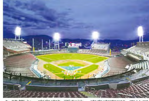
▷建築主＝広島市▷所在地＝広島市南区▷発注元＝環境デザイン研究所▷延べ床面積＝3万9,524㎡▷構造＝S・RC造地上7階建て▷竣工年月＝2009年3月 (写真提供：東芝ライテック)
