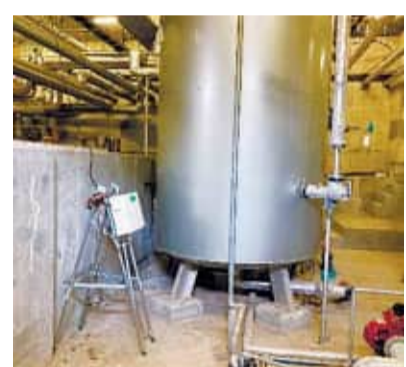
▲既存施設のエネルギー消費量を計測している様子
